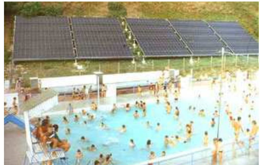
Piscine chauffée à Laval (53)
