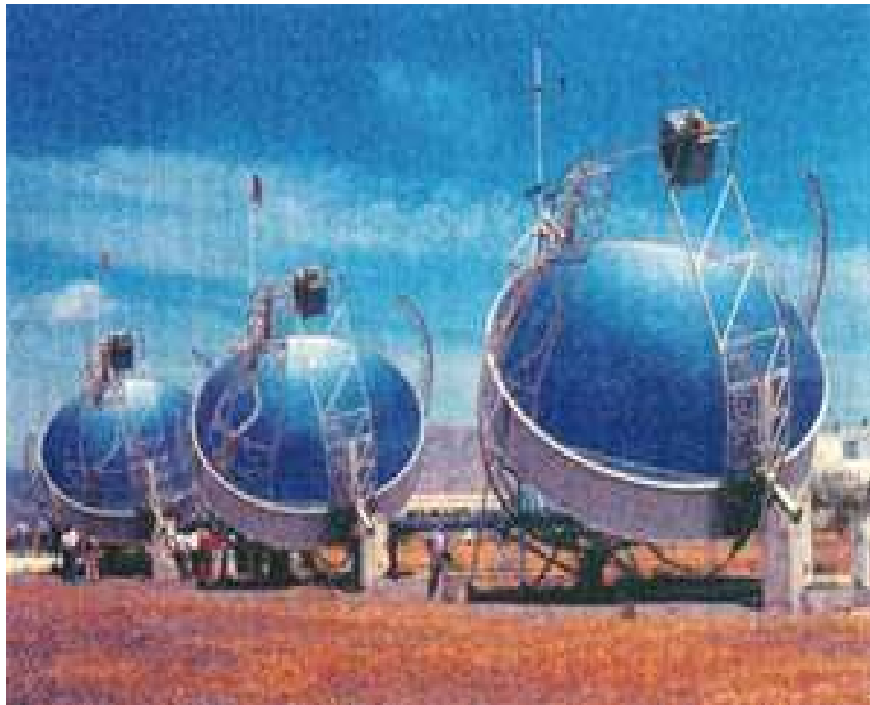
Capteurs paraboliques à moteur Stirling au foyer (Espagne)
