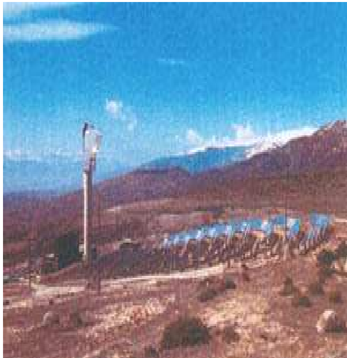
La centrale à tour Thémis (France)
